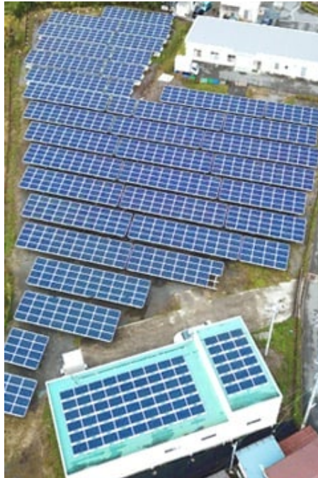
高崎倉賀野発電所 (最大発電出力407kW)
